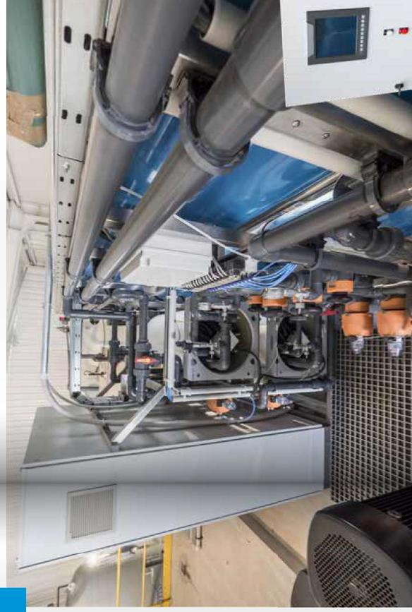
Elektrodejonizacja wody (EDI) jest nowoczesną, w pełni zautomatyzowaną technologią, pozwalającą uzyskać wodę zdemineralizowaną o bardzo wysokich parametrach jakościowych. Woda uzyskiwana metodą elektrodejonizacji jest coraz częściej wymagana w energetyce oraz wielu innych gałęziach przemysłu.
