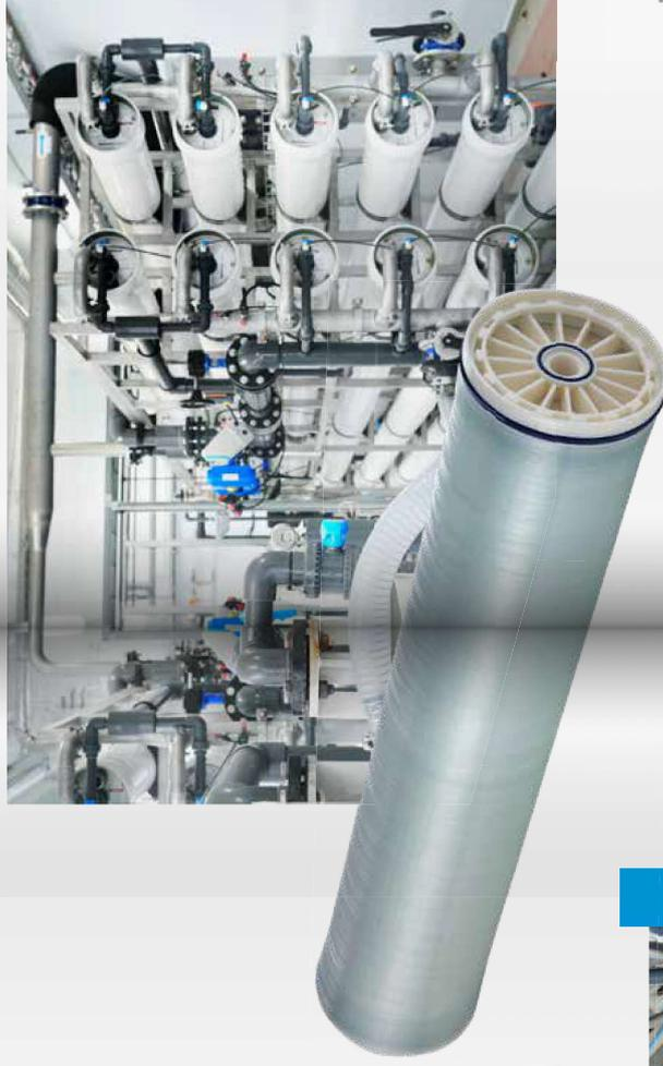
Systemy odwróconej osmozy stanowią jeden z podstawowych produktów Watersystem. Oferowane przez nas urządzenia (RO) przeznaczone są do produkcji wody zdemineralizowanej. Umożliwiają one wysoką redukcję soli rozpuszczonych w wodzie, nawet do 99 procent.
