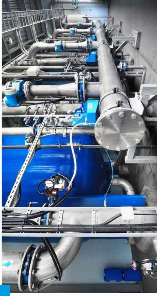
Filtracja wody na filtrach ciśnieniowych, wykorzystywana jest do usuwania z wody związków rozpuszczonych, tj. żelaza i manganu, które pogarszają jej smak i barwę.
