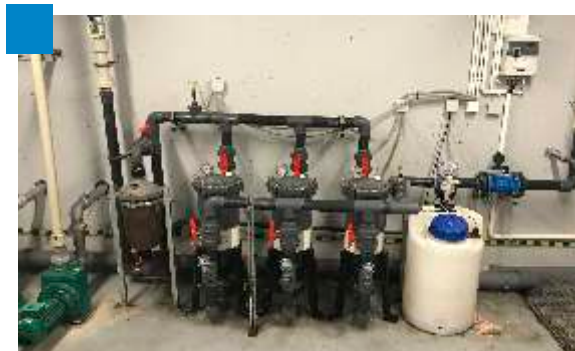
Biurowiec Warsaw Spire, Warszawa
